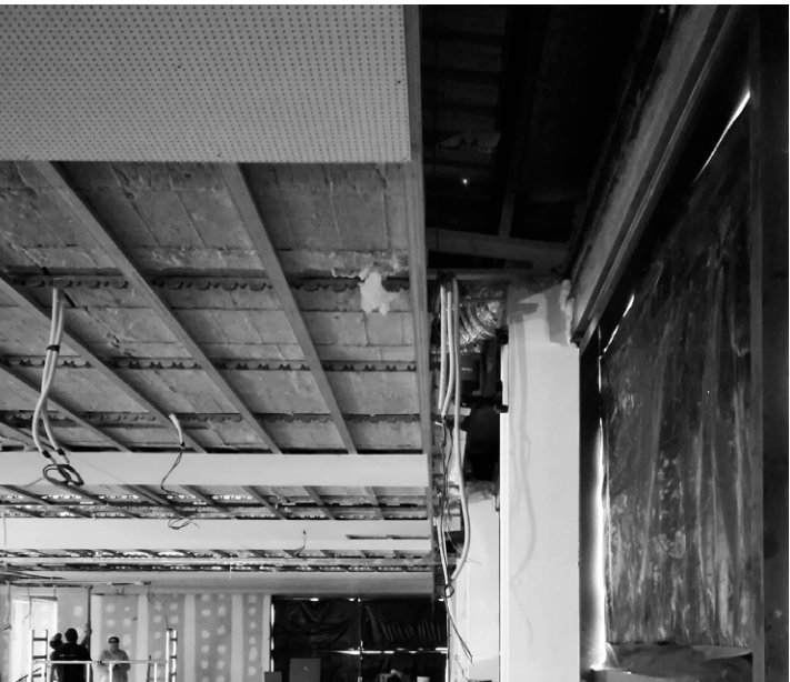
Aislamiento | Cierre de tabiquería y falsos techos
