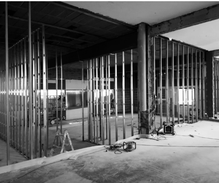
Replanteo | Tabiquería | Premarcos | Guías suelo/techo
